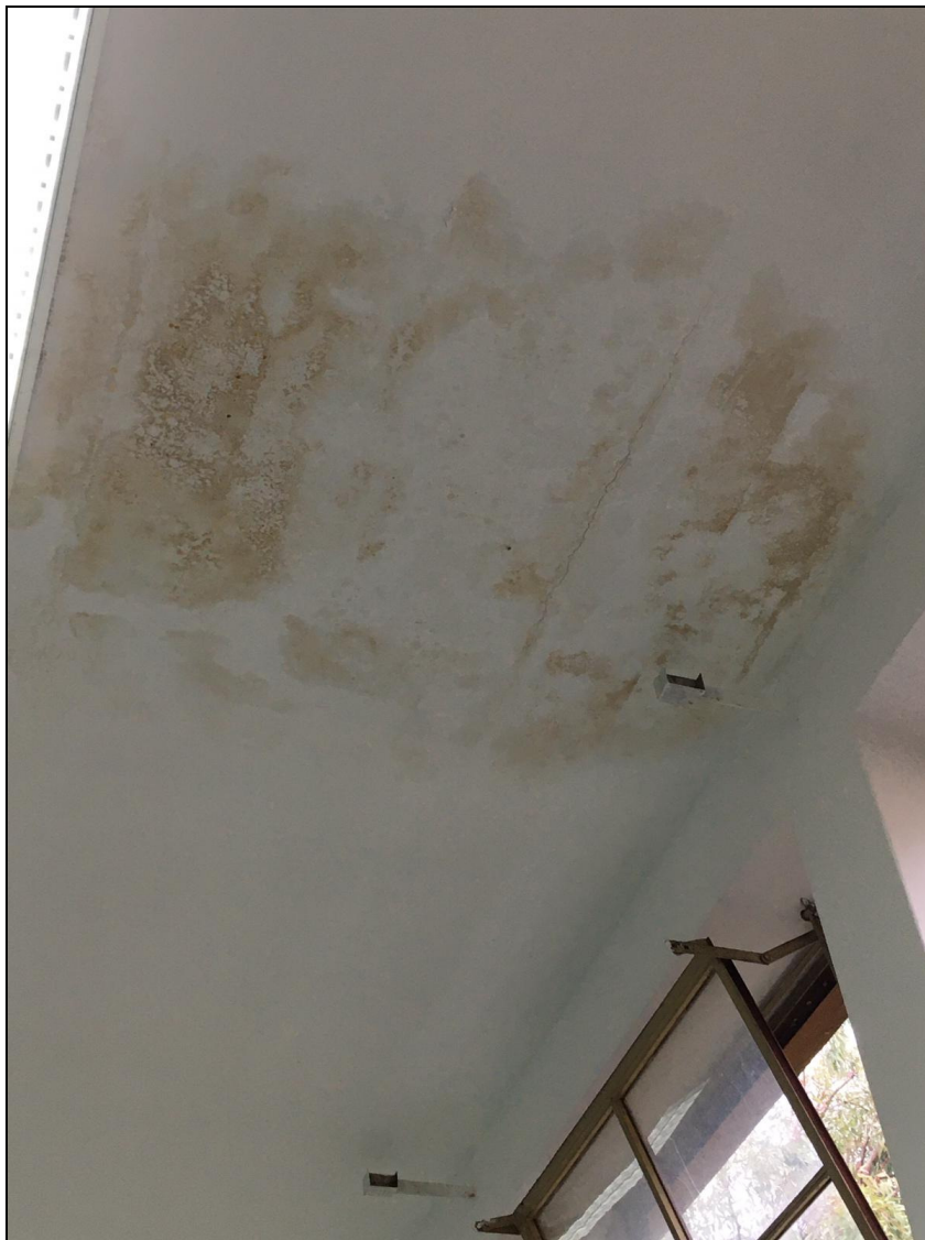
Foto dell'intradosso del solaio dell'aula del secondo piano
